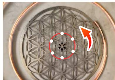
d) Drehen Sie die BDL so, dass der mittige Kreis auf den Metallbolzen zu liegen kommt. So kann die BDL das Gewicht der Sekundärspule gut tragen.
